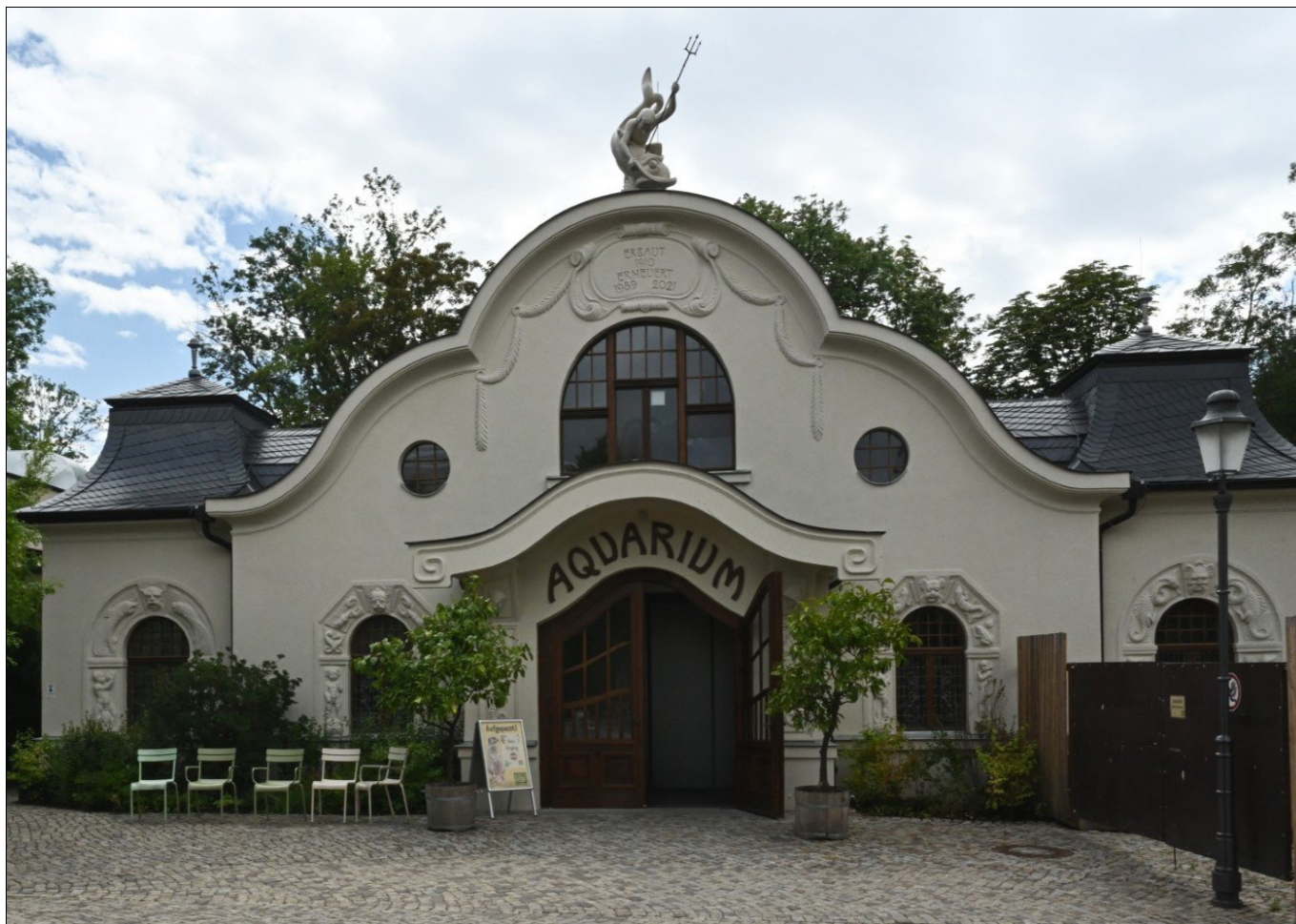
Stará, ale renovovaná budova původního akvária. V průčelí budovy je vidět současný východ z expozičních prostor.
